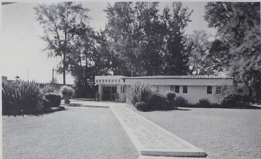
Instalaciones provisionales de la Unidad Guadalajara
